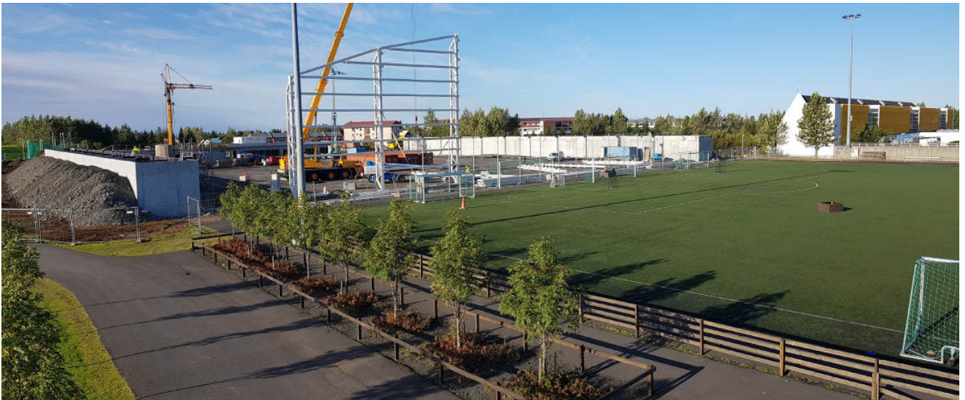
Framkvæmdir við fjölnota íþróttahús á íþróttavallarsvæðinu við Engjaveg.
