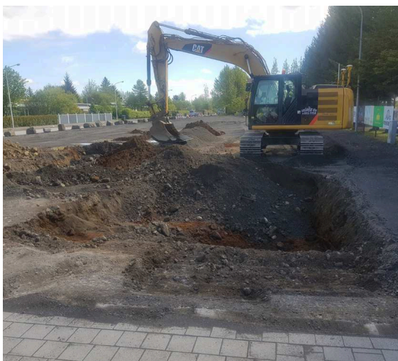
Framkvæmdir á bílastæðinu við Tíbrá.
